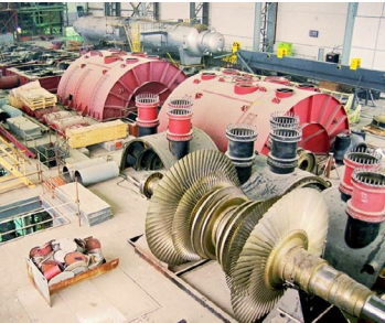
Jaderná elektrárna Temelín Pohled na díly 1000MW parní turbíny v Jaderné elektrárně Temelín během montáže.
